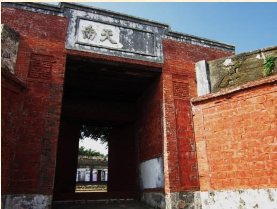
▲ 旗後砲臺大門
